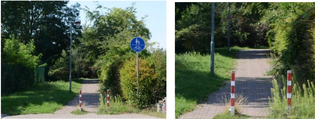
Abbildung 10 Beispiel für Einwachsungen (Quelle: BSV Rödel und Pachan GbR)
