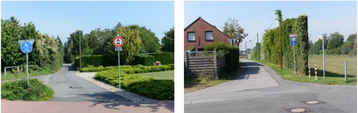
Abbildung 20 Gestfeldstraße (Quelle: BSV Rödel und Pachan GbR)
