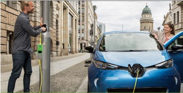
Abbildung 26 Laden eines Elektroautos an vorhandener Infrastruktur (Doppelnutzung Straßenlaterne / Ladesäule) (Quelle: ubitricity Gesellschaft für verteilte Energiesysteme mbH)
