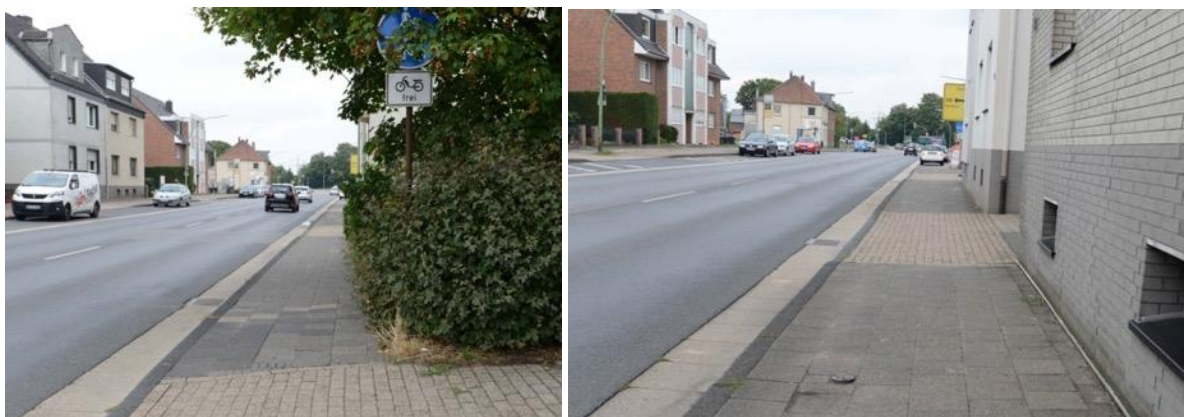
Abbildung 53 Engstelle an der Prinzenstraße Nicht einsehbare Grundstückzufahrt (Quelle: BSV Rödels und Pachan GbR)
