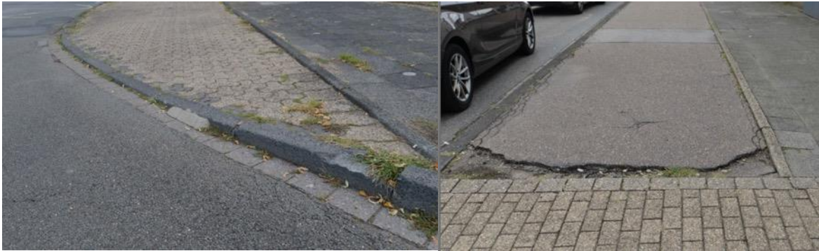
Abbildung 57 Schlecht befahrbare Bordabsenkung, defekte Fahrbahn (Quelle: BSV Rödel und Pachan GbR)
