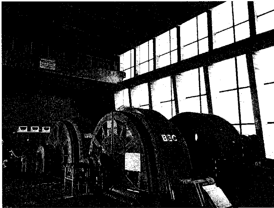
Abbildung 6: Exemplarische Teilansicht Steuerzentrale in der obersten Etage mit der Glasfassade
