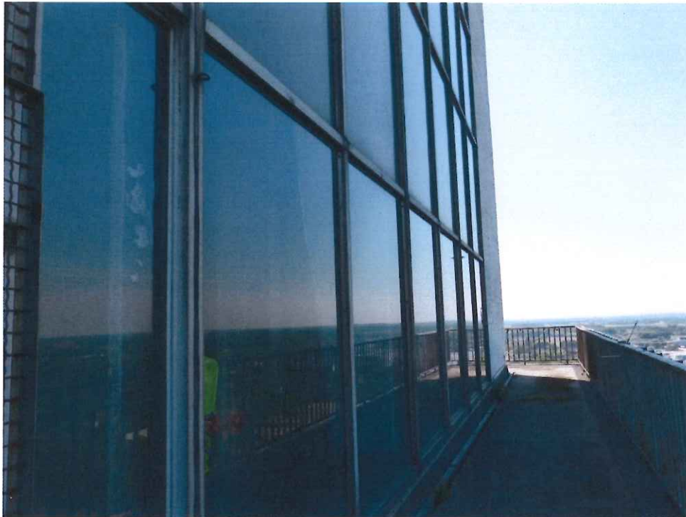
Abbildung 8: Exemplarische Teilansicht auf die Glasfassade auf der Westseite
