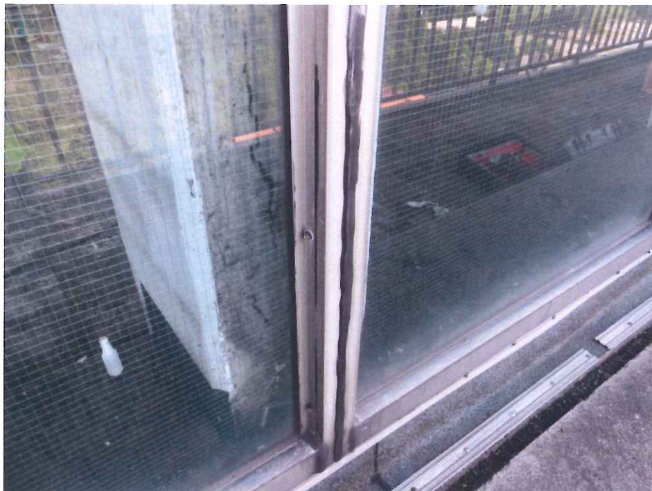
Abbildung 9: Exemplarische Teilansicht der Verbindungspunkte der Glasfassade
