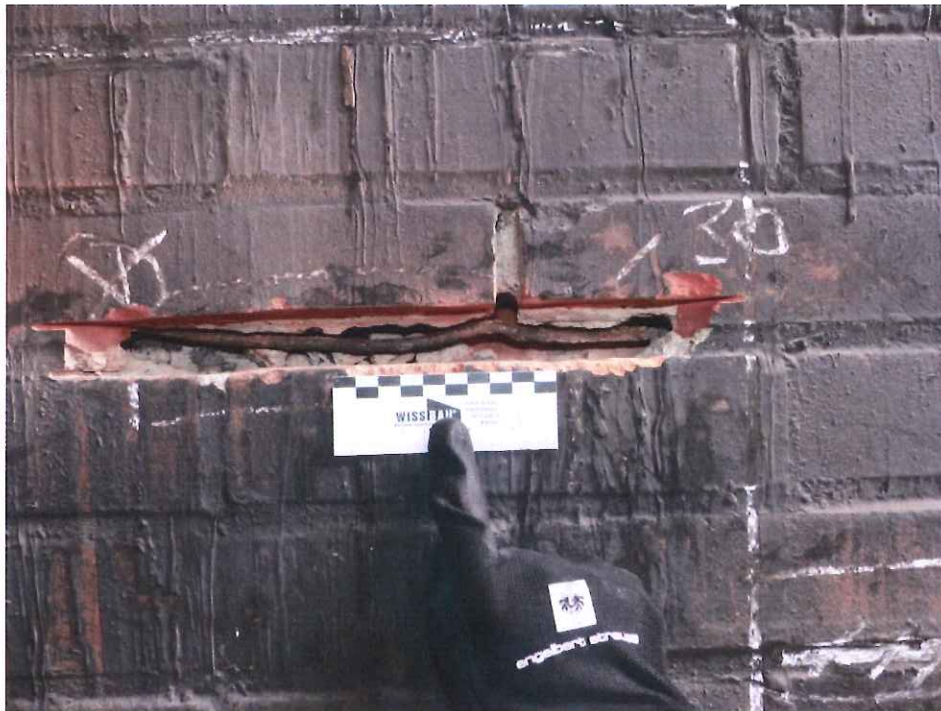
Abbildung 45: Exemplarische Ansicht einer Öffnung an der Klinkerfassade zur Beurteilung der Verankerung
