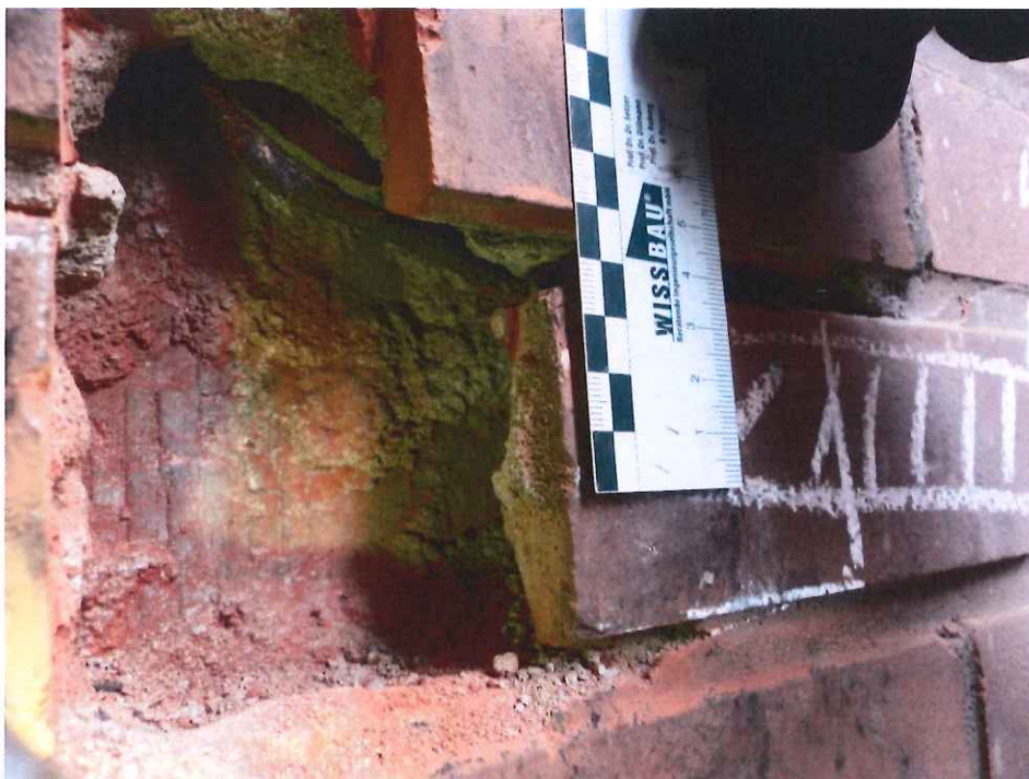
Abbildung 46: Weiter exemplarische Ansicht einer Öffnung an der Klinkerfassade zur Beurteilung der Verankerung mit vollflächiger Vermörtelung
