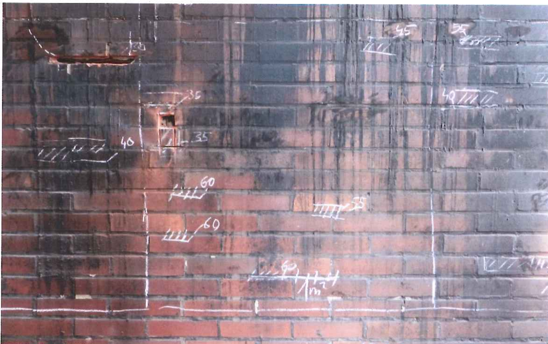
Abbildung 44: Exemplarische Darstellung der gemessenen Ankerpunkte
