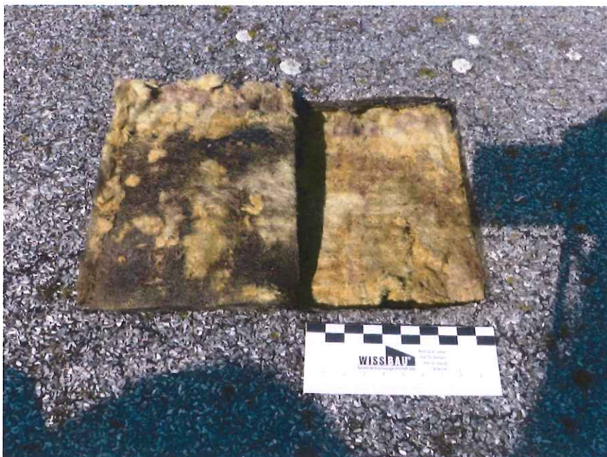
Abbildung 42: Exemplarische Ansicht der Dachöffnung
