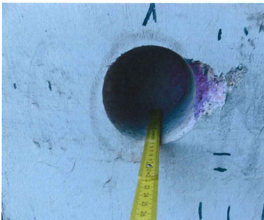
Abbildung 34: Exemplarische Ansicht einer Bohrkernentnahmestelle
