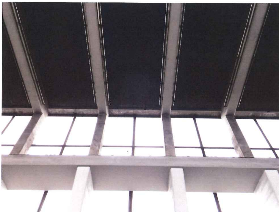
Abbildung 7: Exemplarische Teilansicht der Decke der Steuerzentrale in der obersten Etage
