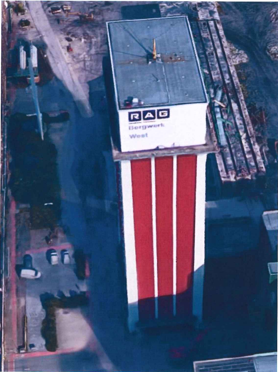
Abbildung 4: Südansicht des Förderturms (Quelle: Google Maps)
