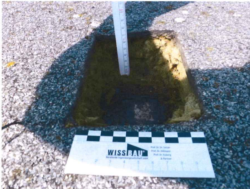
Abbildung 43: Weitere exemplarische Ansicht der Dachöffnung
