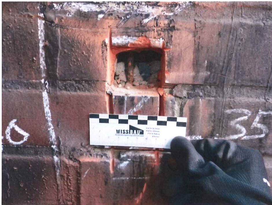
Abbildung 47: Exemplarische Ansicht einer Öffnung mit Längsverankerung
