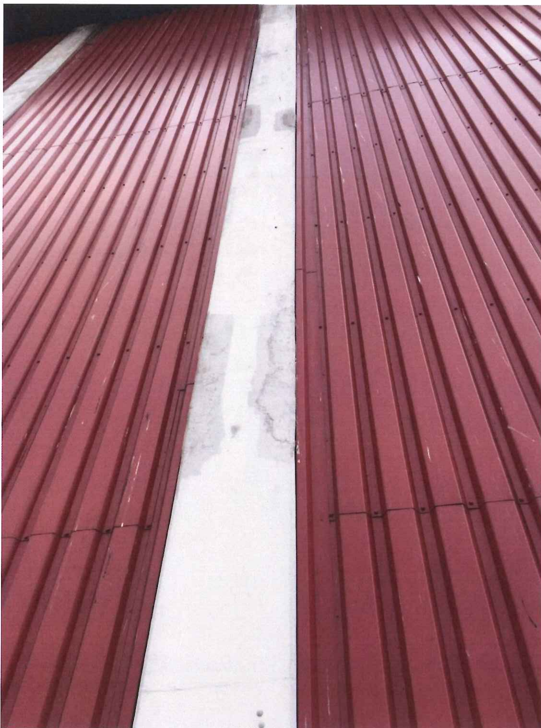
Abbildung 11: Ansicht einer Stahlbetonstütze an der Nordseite mit mehreren reprofilierten Stellen
