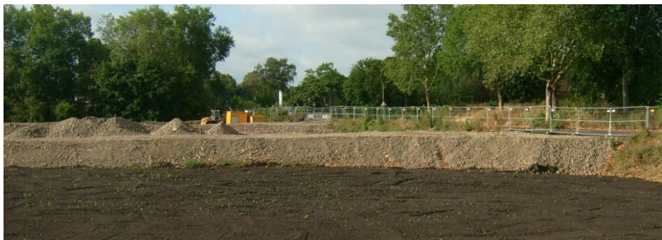
Höhenunterschied zwischen Straße und Baugrundstück
