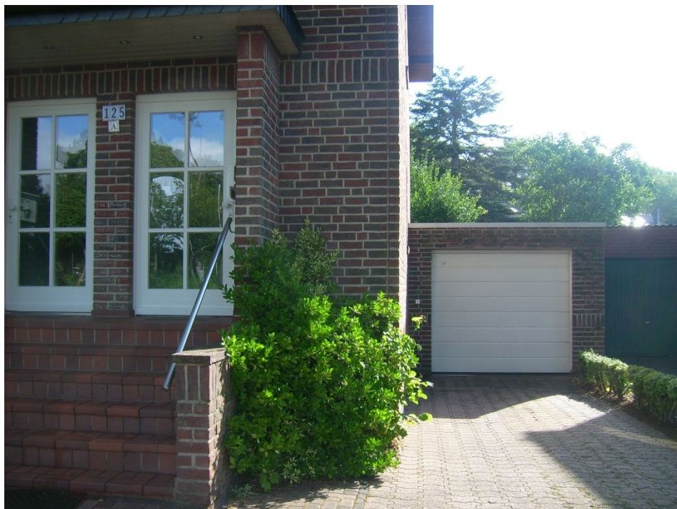
Garage hinter der Bauflucht und in Material des Wohnhauses
