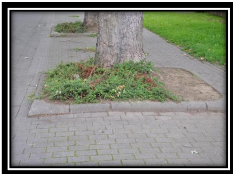
Die Baumscheiben sind mit ca. 5m 2 relativ groß. Teilweise ist die Pflanzscheibe einseitig verdichtet.
