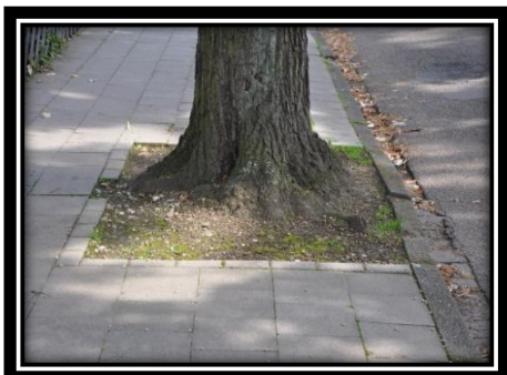
Zu kleine Baumscheibe bei der Mehrzahl der Bäume (2,75 m 2 ).
