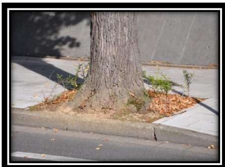
Zu kleine Baumscheibe und zusätzlich der Verdacht auf Wurzelschäden durch Baumaßnahmen.
