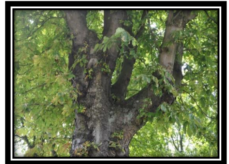
Die Anbindungen sind aus Sicht der Verkehrssicherheit sehr bedenklich. Höhlungen und Faulstellen schwächen die ungünstigen Astanbindungen zusätzlich.
