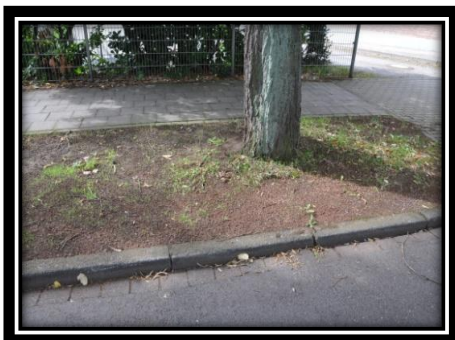
Die Baumscheiben sind stellenweise stark verdichtet. Die Versorgung der Wurzeln mit Luft, Wasser und Nährstoffen ist eingeschränkt.
