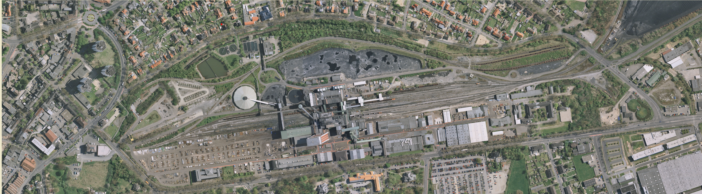
Luftbild Bergwerk West, Zechengelände Friedrich Heinrich
