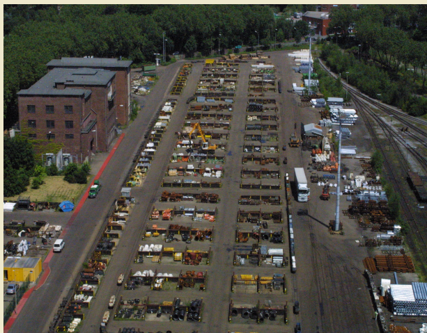
Blick auf das nördliche Zechengelände in Richtung ABC-Gebäude
