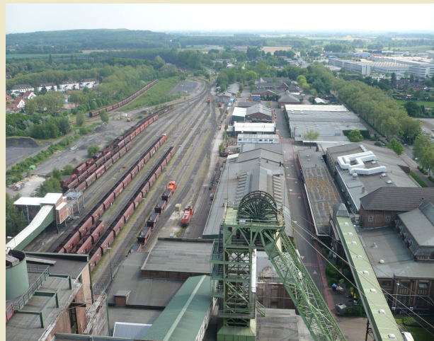
Blick vom Förderturm Schacht I auf das südliche Zechengelände
