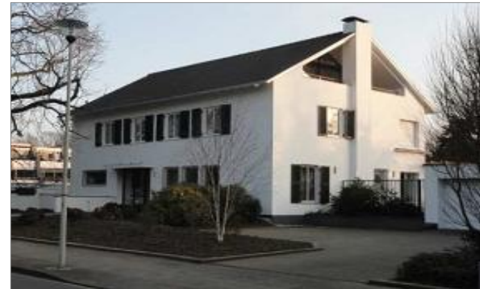
Traufständiges Gebäude mit weißem Putz und flach geneigtem Satteldach ohne Dachaufbauten
